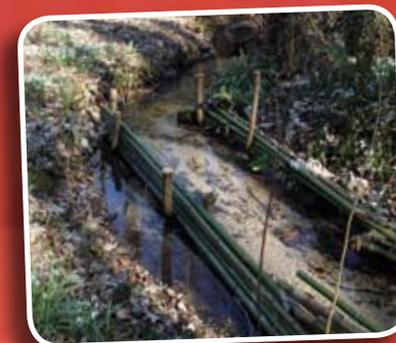
▲ Les bambous coupés et ébranchés servent d'étais et permettent de canaliser le cours des ruisseaux qui alimentent la rivière
